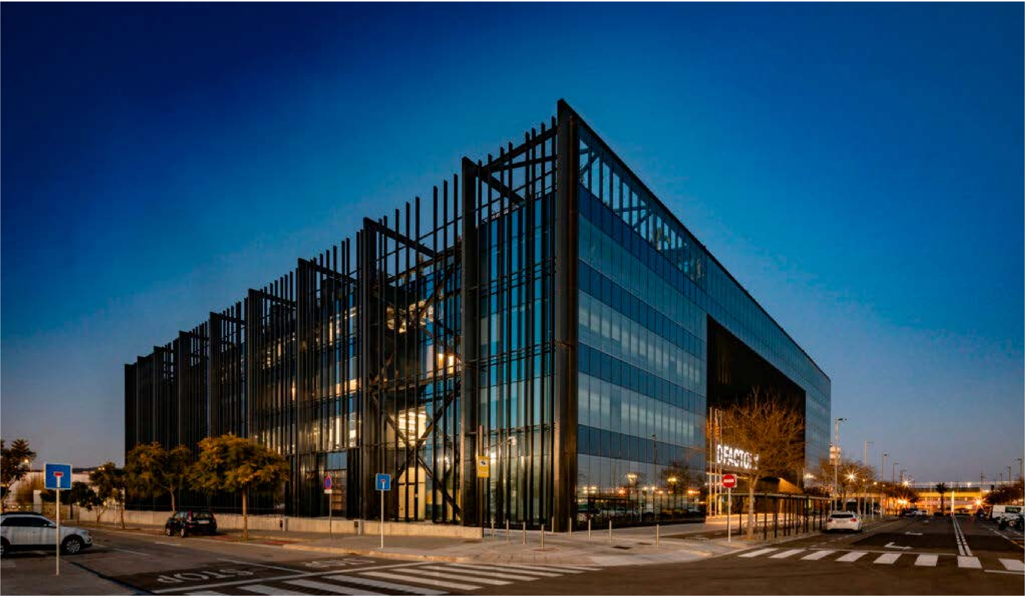
Edificio DFactory | Turull Sørensen
