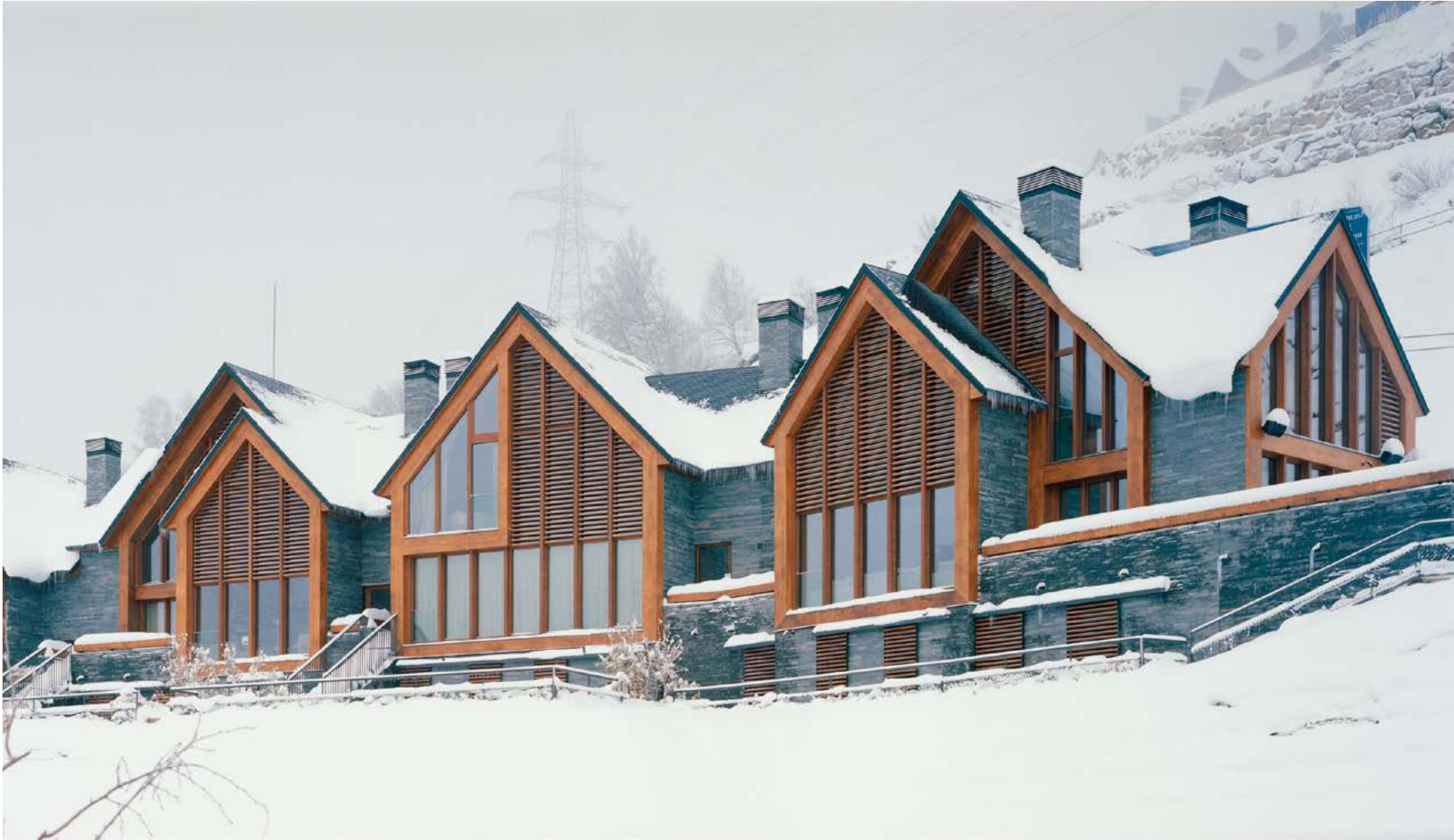
38 viviendas Pleta Arriu | Mano Arquitectura
