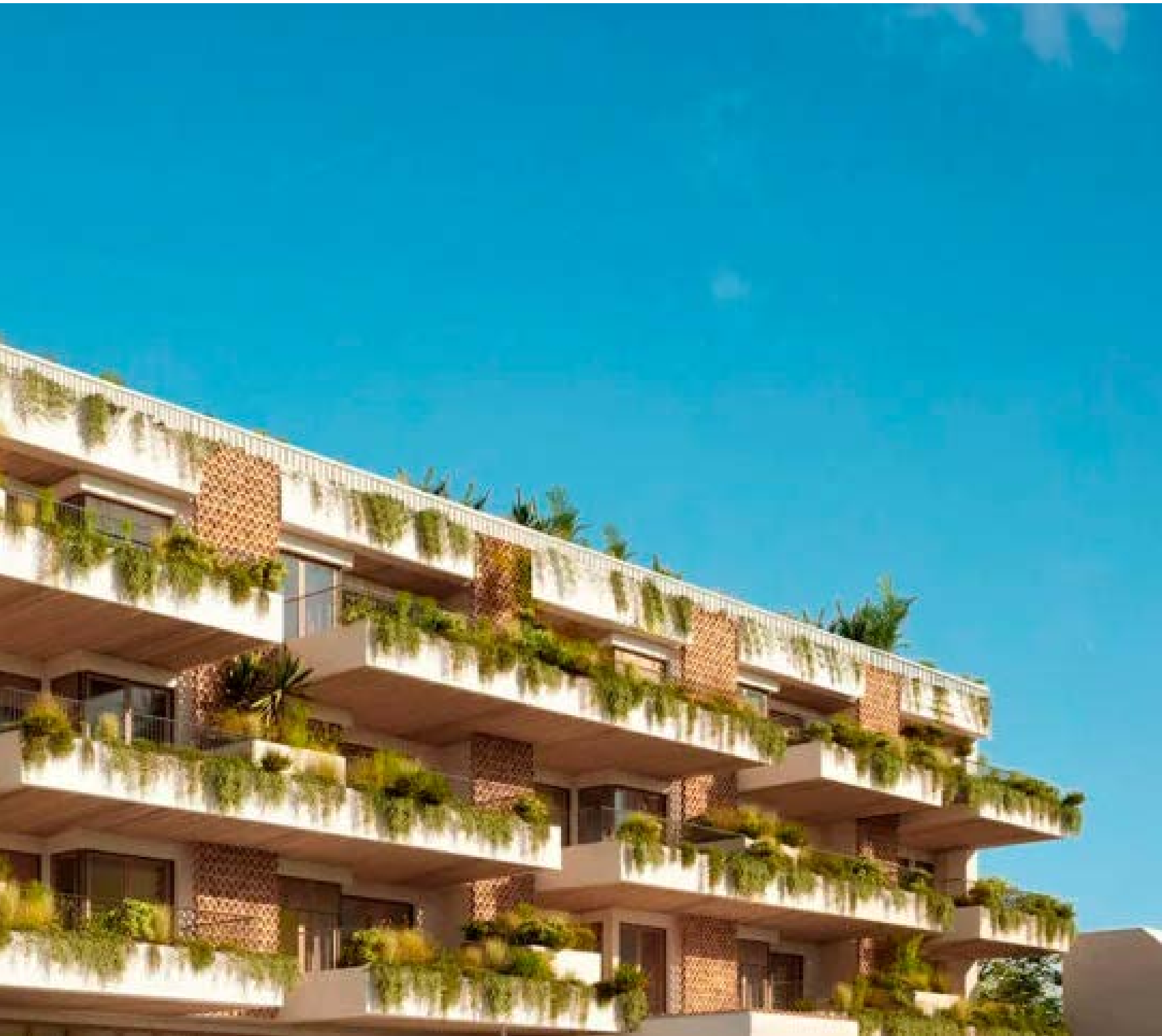
Ca N'Espanyol | Impar Arquitectura
