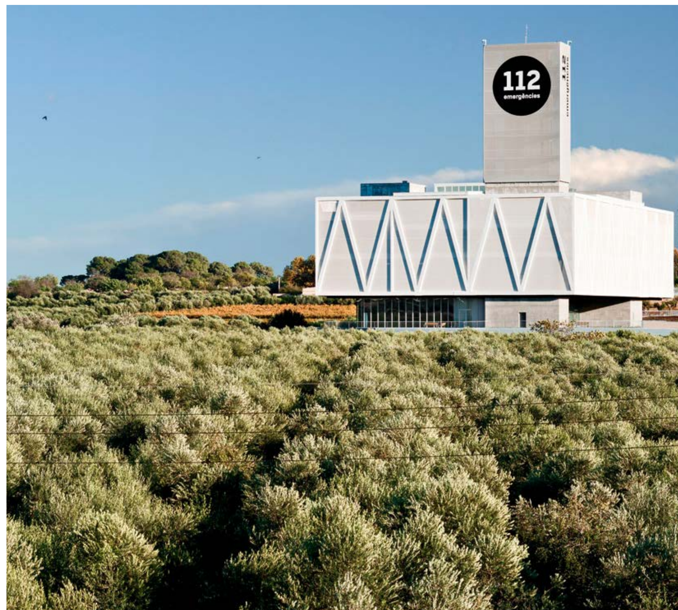
Edificio Emergencias 112 | IDOM | © Adrià Goulla
