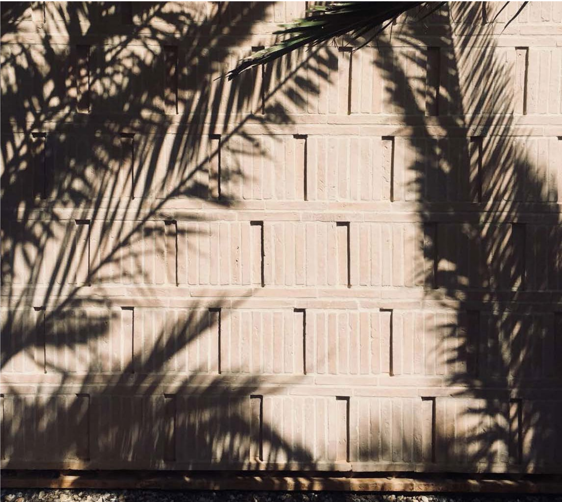
Vivienda Sotoalto en Cádiz | Paloma Cañizares Office
